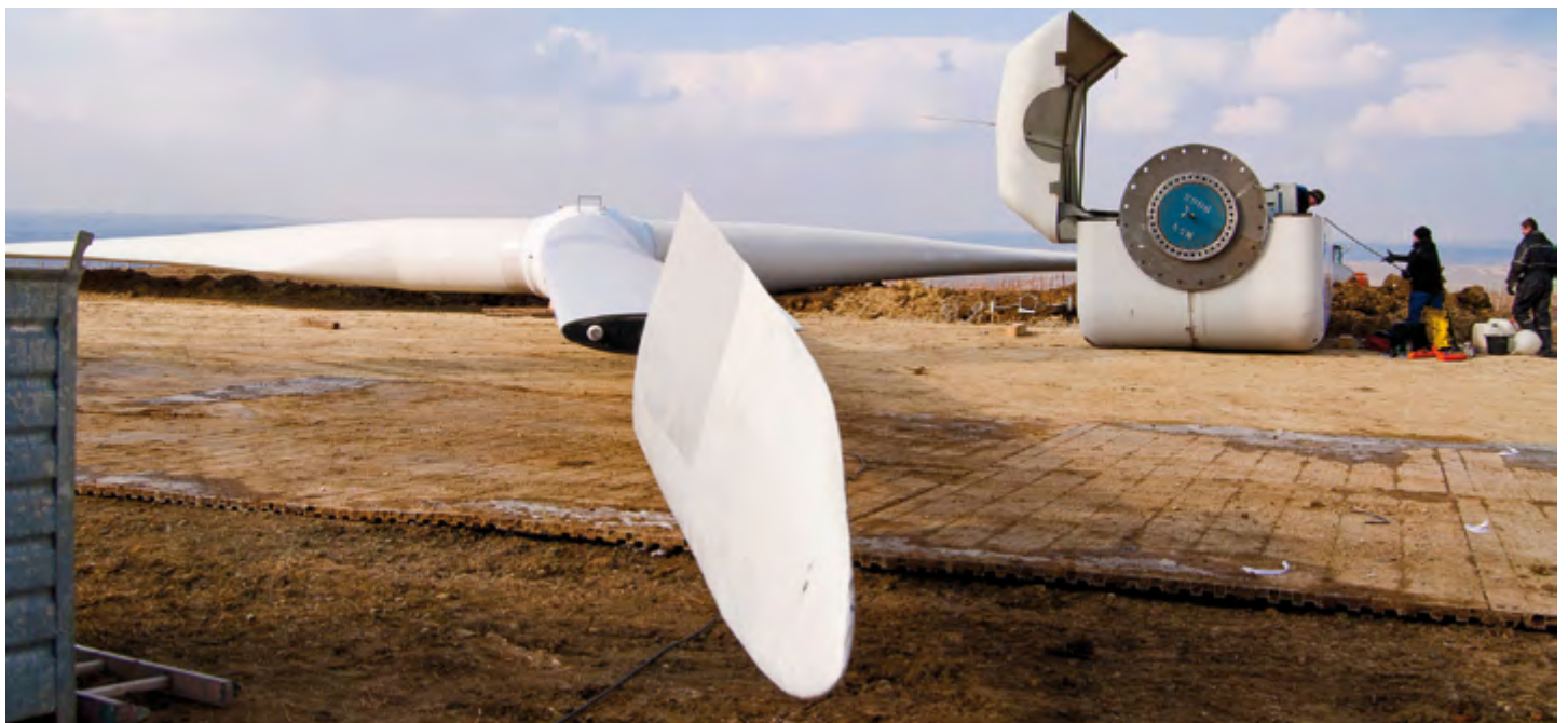
Rückbau einer Anlage im rheinland-pfälzischen Framersheim
